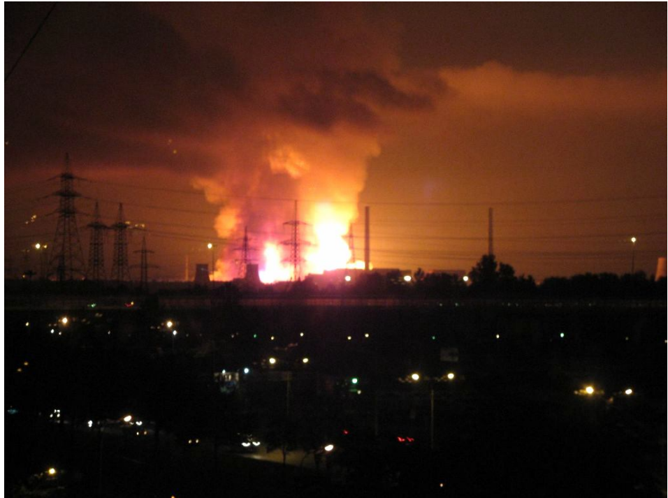
Рис. 1. Авария на трубопроводе под Санкт-Петербургом
