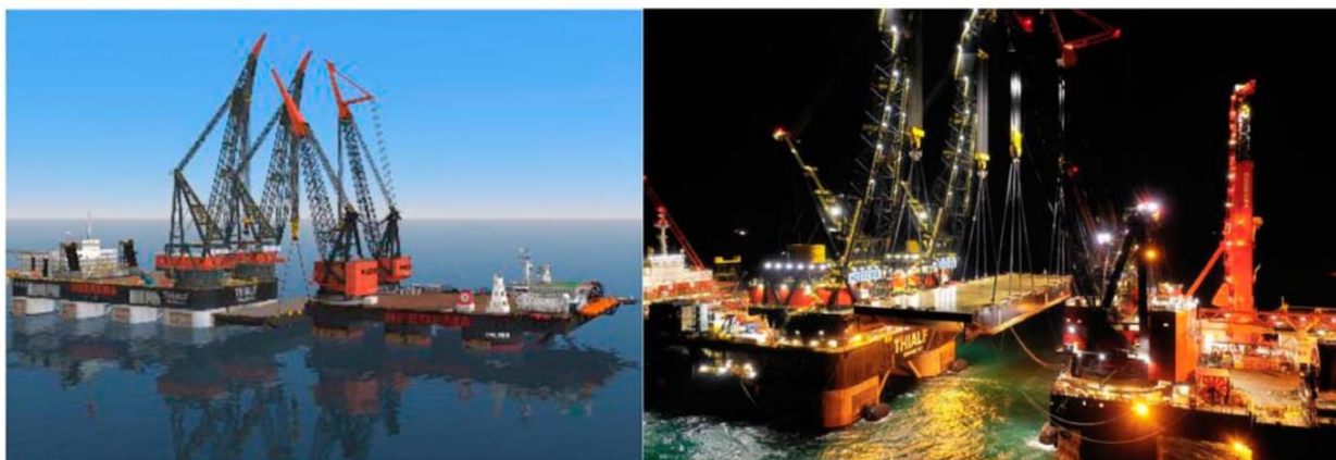
Рис. 5. Цифровой двойник Quad Lift (подъемника с четырьмя кранами) производства «Thialf and Balder» (слева) и Quad Lift на шельфе (справа) [5, 6]
